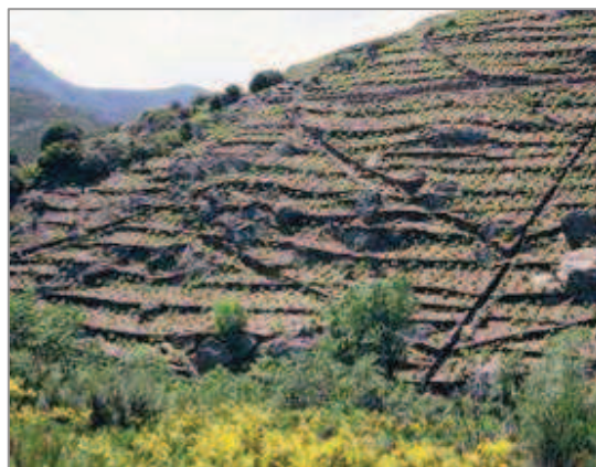
Figure 53 : Le vignoble en terrasse et le réseau de canaux d'évacuation des eaux pluviales
